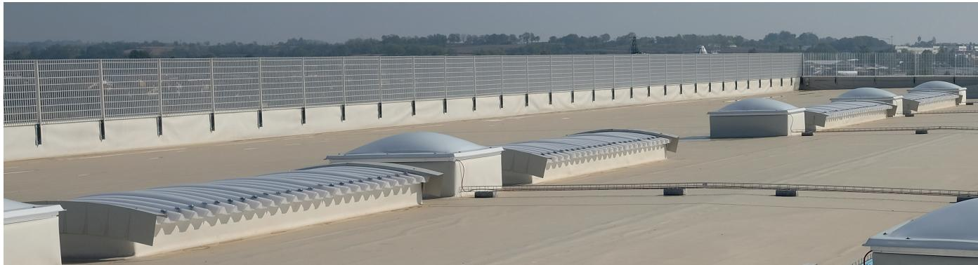
Les couvertures **DECK** sont réalisées en continu avec un support métallique en acier galvanisé et support d'étanchéité en carton feutre bitumé sur lequel peuvent être appliquées les différentes gaines d'étanchéité et couches pour la protection de la couverture.
